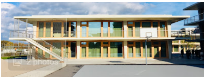
Rue des Arpenteurs 9, au sous-sol du parascolaire des Vergers
